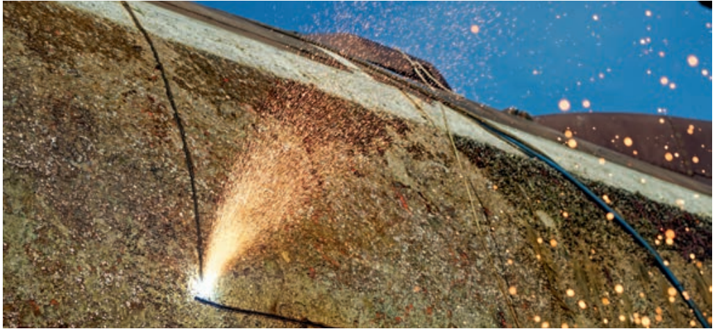
KSHでのリサイクルの最初のステップ。切断トーチを用いて、U 15潜水艦の艦体からスチール板が取り外されます。
